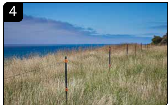
4 Stellen Sie die Zwischenpfähle auf
